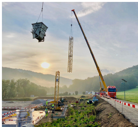
Die Baustelle in ihren Anfängen – hier beim Kranstellen.
