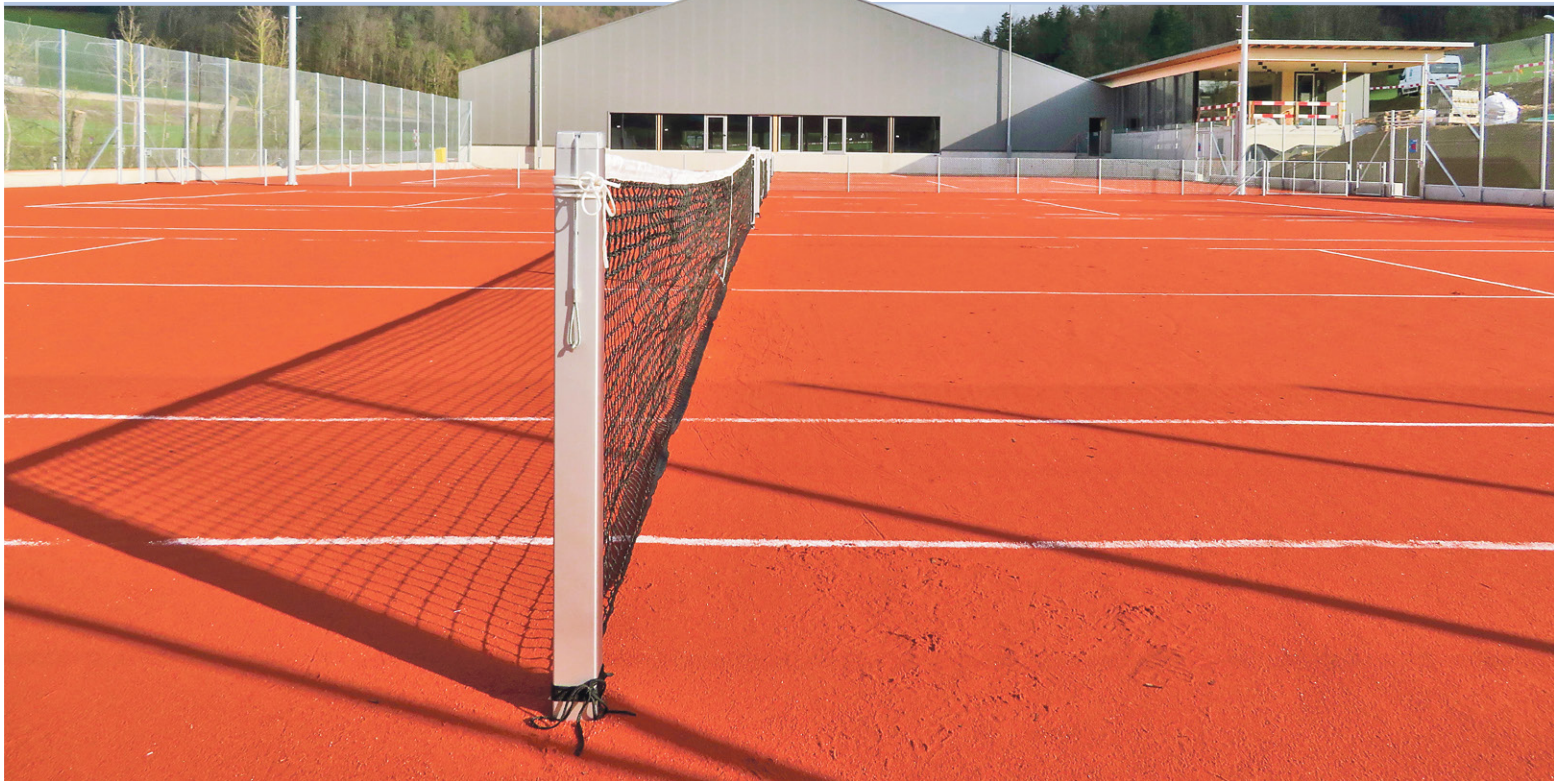
Vier Aussenplätze, drei Plätze in der Halle und ein Clubhaus mit Terrasse bilden die neue Tennisanlage in Gelterkinden.
