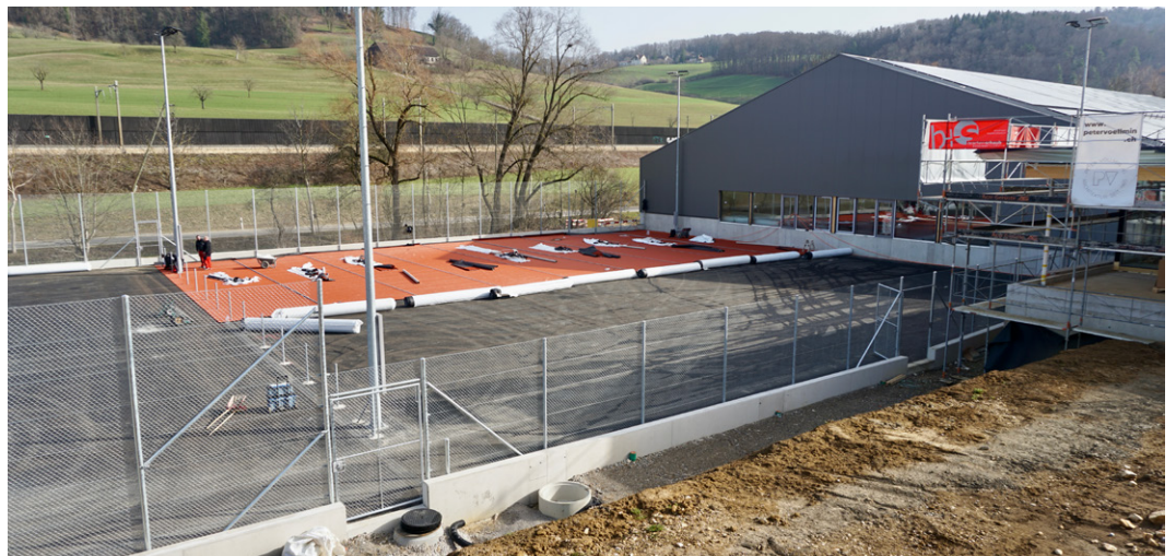
...dann wurden die Halle und die Aussenplätze errichtet.
