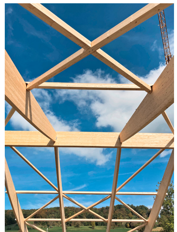
Fällt sofort ins Auge: Holz – und auch Beton – sind die zentralen Bauelemente auf der Anlage.
