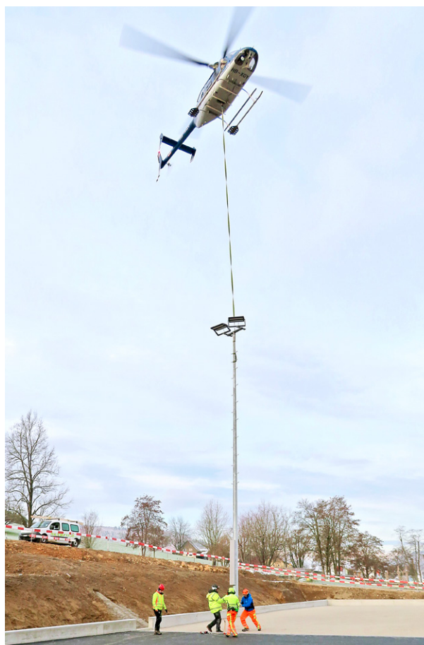
Das Stellen der Lichtmasten für die Beleuchtung der Tennisplätze war im Jahr 1954 mit dem Kran und auch 2021 mit dem Helikopter Schwerstarbeit.
