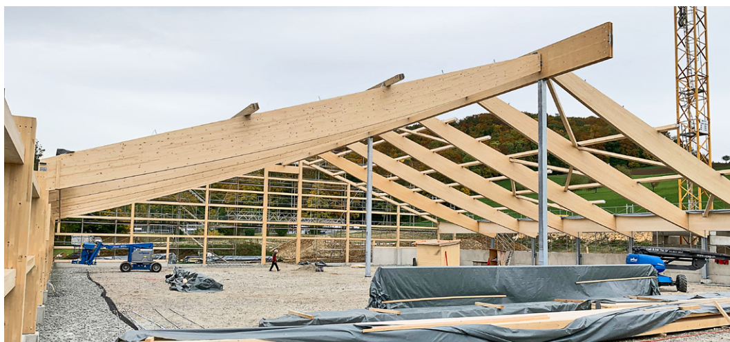
Die Halle wird geprägt von einer mächtigen Holzkonstruktion.
