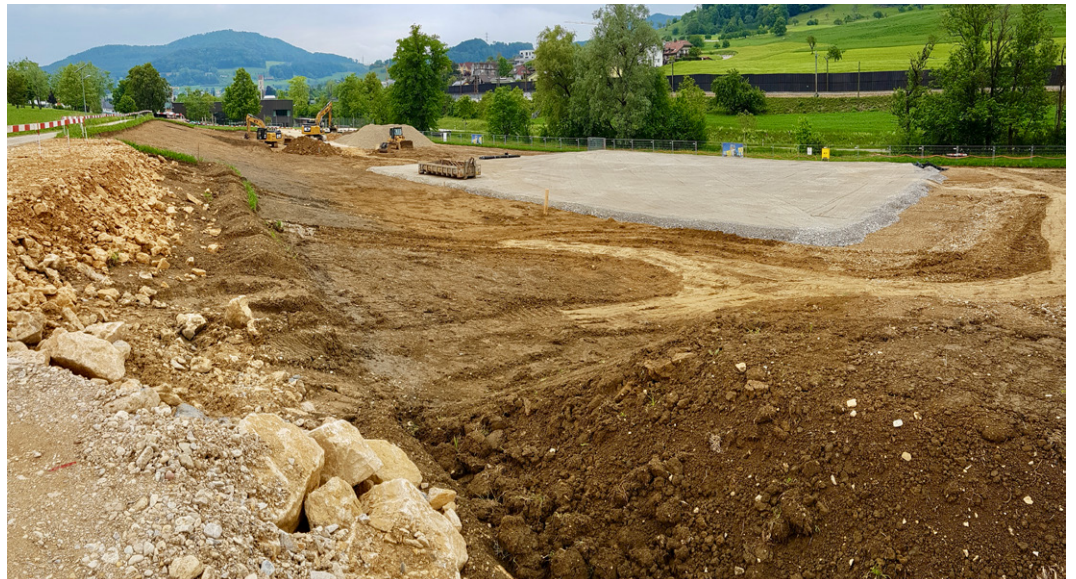
Schritt für Schritt zum Vorzeigeprojekt: Zuerst wurde geplant und das Fundament geschaffen ...
