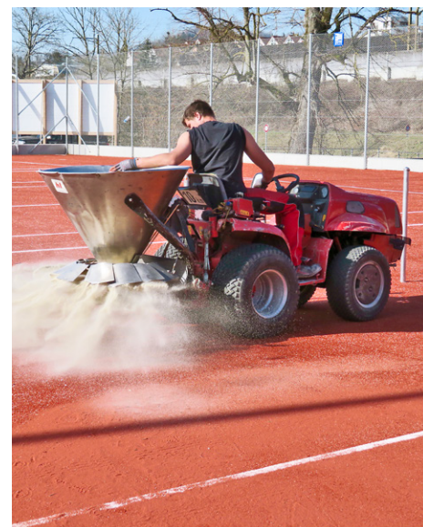
Der Spielbelag wird aufgetragen.
