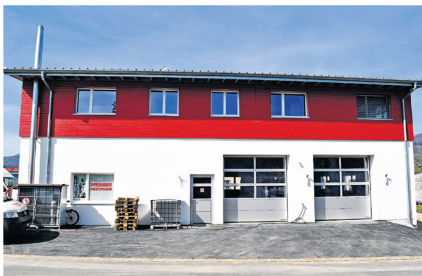
Messer Heizungen ist neu am Zeughausweg 1 in Gelterkinder stationiert.
