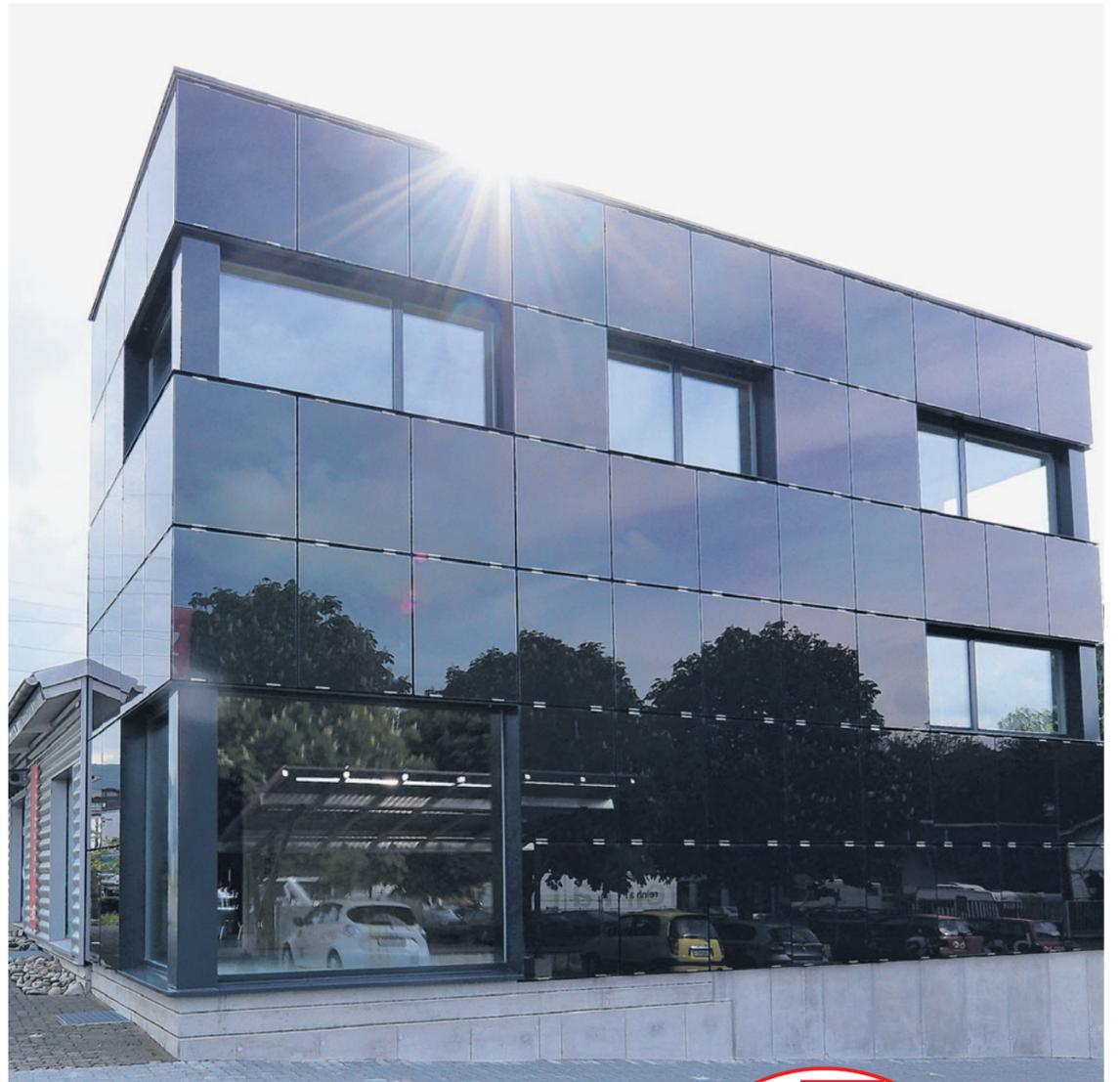
Die Fassade des Anbaus besteht beinahe nur aus Solarpanels.
