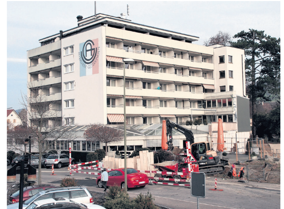
In Gelterkinden wird trotz Baustelle am 23. Dezember im festlichen Rahmen gefeiert.
