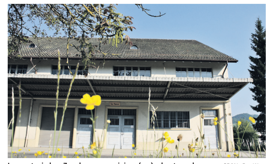
Im spartanischen Zeughaus muss einiges (um)gebaut werden. Bild Nadine Küng
