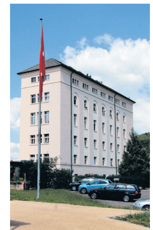
Bereits im 14. Jahrhundert war die Hägler-Handelsmühle Teil eines Gewerbezentrum.
