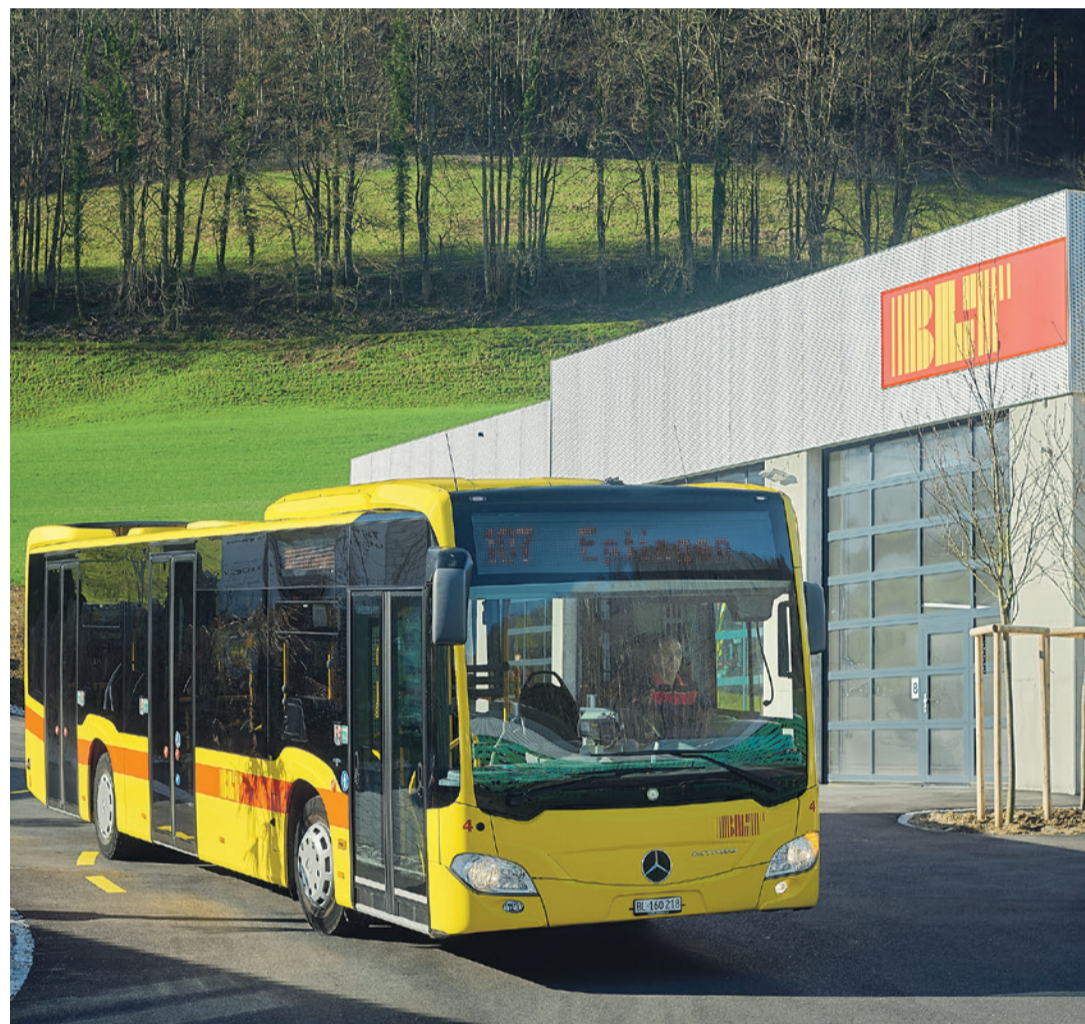
Das neue Depot in Eptingen bietet viel Platz für die Busse der BLT.
