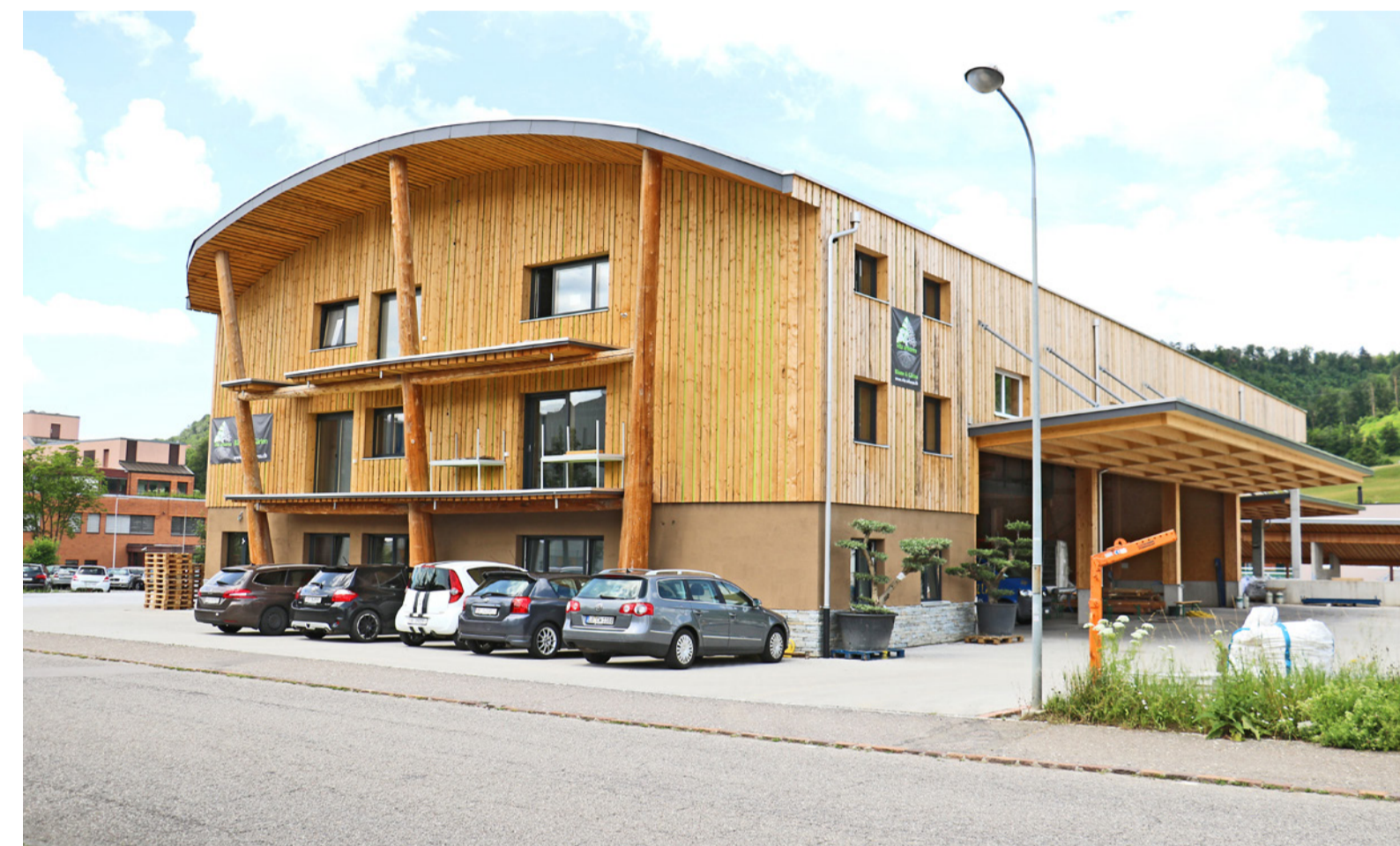
Der neue Standort an der Gstaadmattstrasse mit Büroräumlichkeiten und Werkhofhalle.
