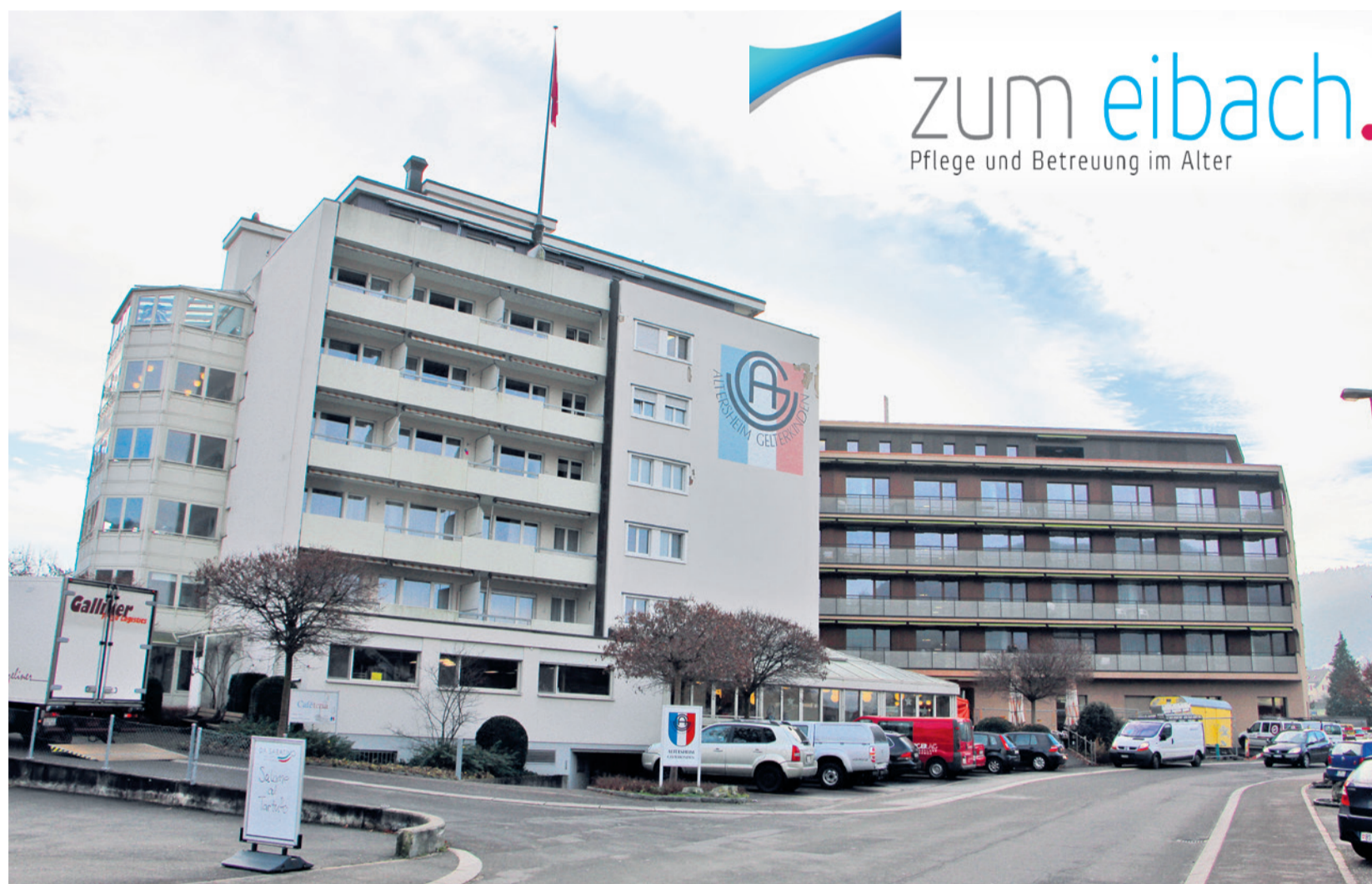
Mit dem Umzug vom alten (vorne) ins neue Gebäude (hinten) hat sich für die Bewohner des Alters- und Pflegeheims einiges verändert.
