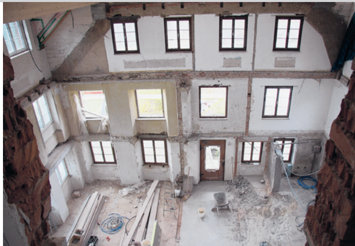
Im «ausgehöhlten» Teil des Hauses entstehen fünf Wohnungen.
