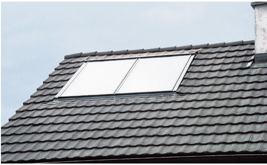
Die Montage von Solaranlagen gehört ebenfalls zu den Tätigkeiten der Firma.
