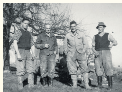
Wasserleitungsbau in Rünenberg: Arnold Flüeler, Brunnenmeister; Grabarbeiter Arnold Ruepp, Heini Schaffner und Hans Ruepp
