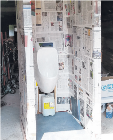
Dieses Pissoir verhindert unangenehme Gerüche.
