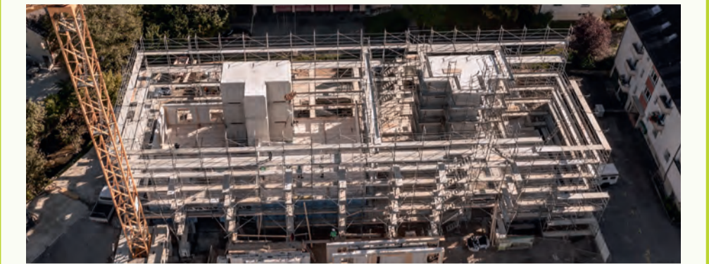
Der Blick von oben während der Bauphase des «ErgHolz-Parks». Bild zvg
